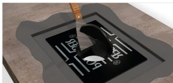
Recortar la pieza de refuerzo (inferior)
