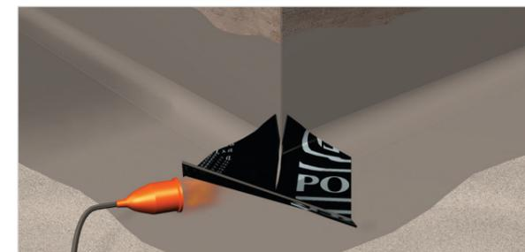
Aplicación de la pieza de refuerzo interior. Totalmente adherida.
