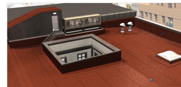
En cubierta adherida, con protección ligera, se hubiera imprimado toda la superficie.
