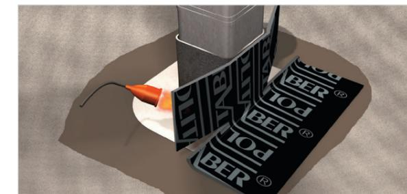
Aplicación de pieza de refuerzo inferior.
