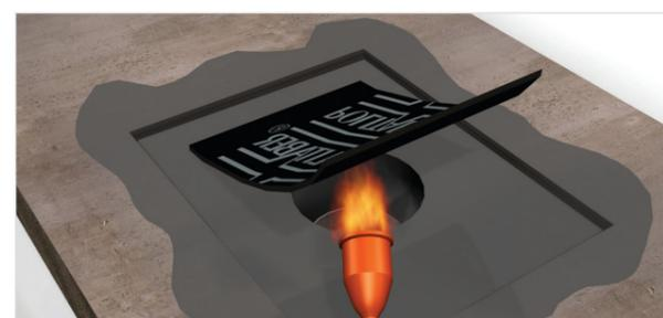
Soldar la pieza de refuerzo (inferior)
