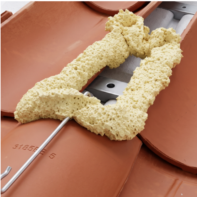
Cordón de espuma de poliuretano aplicado sin invadir el canal de evacuación de agua.
