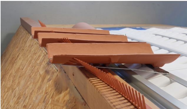
Imagen de fijación de gancho curvado largo al perfil U
