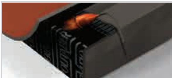
APLICACIÓN DE LA BANDA DE ADHERENCIA.
