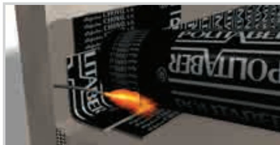
APLICACIÓN DE LA MEMBRANA.
