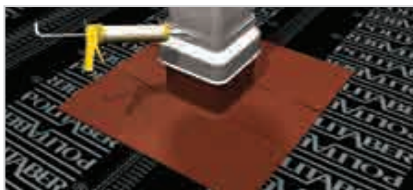
APLICACIÓN DE UN SOMBRERETE. SELLADO DEL MISMO CON MASILLA.
