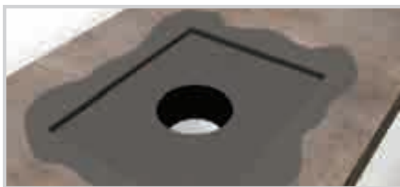
REBAJAR LA ZONA DE REFUERZOS E IMPRIMAR EL SOPORTE.
