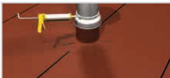
APLICACIÓN DE UN SOMBRERETE. SELLADO DEL MISMO CON MASILLA.
