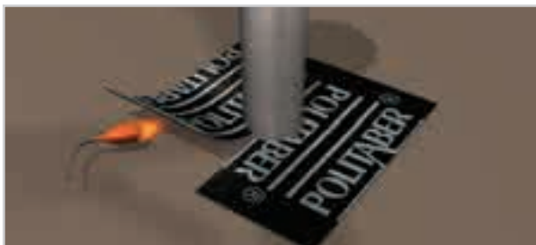
SOPORTE IMPRIMADO. APLICACIÓN DE PIEZA DE ADHERENCIA INFERIOR.
