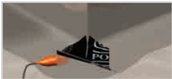
APLICACIÓN DE LA PIEZA DE REFUERZO INFERIOR. TOTALMENTE ADHERIDA.
