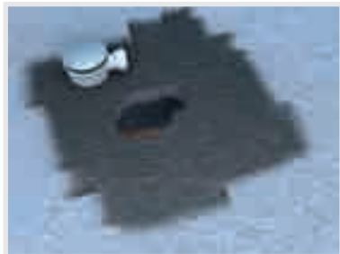
Imprimir inicialmente la zona en la que se aplica el SANIBRIC. (O toda la superficie a impermeabilizar).
