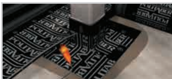
APLICACIÓN DE LA MEMBRANA IMPERMEABILIZANTE.
