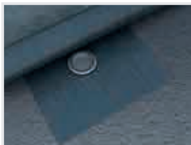
Aplicar el rollo sobre la pieza y el forjado. Al tiempo que se retira el plástico siliconado.
