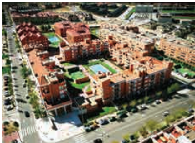
VIVIENDAS EN BOADILLA DEL MONTE MADRID
