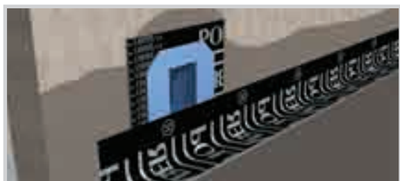
APLICAR BANDA DE REFUERZO. ADHERENTE.
