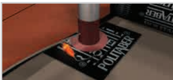
APLICACIÓN DE LA MEMBRANA IMPERMEABILIZANTE.
