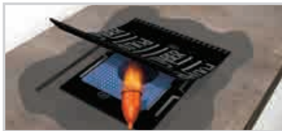
SOLDAR LA PIEZA DE REFUERZO. (Superior).
