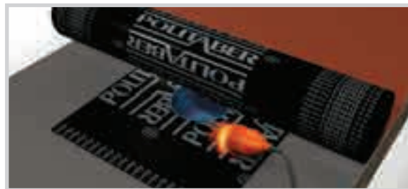
APLICAR LA MEMBRANA IMPERMEABILIZANTE.
