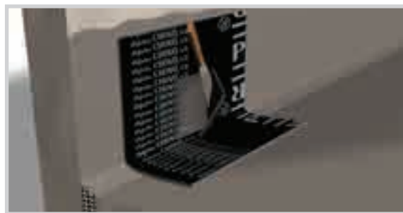
SOLDAR LA PIEZA DE REFUERZO (Inferior) Y PERFILAR AL BORDE DE LA BAJANTE.
