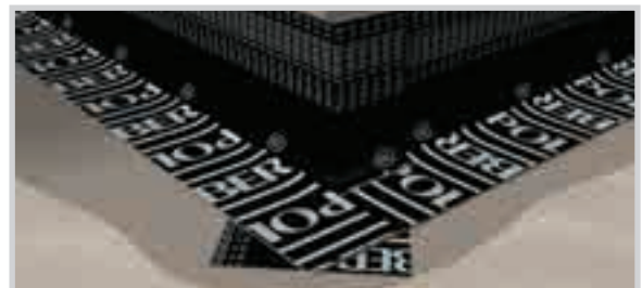
APLICACIÓN DE LAS BANDAS DE REFUERZO.
