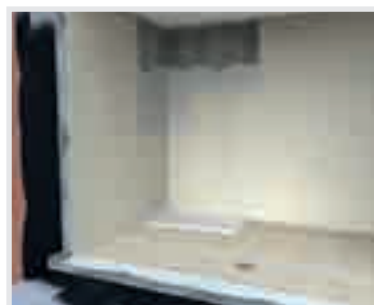
Aplicar plato de ducha y alicatar con cemento cola y cerámica.
