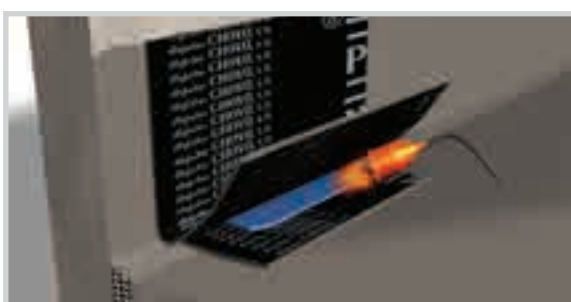
SOLDAR LA PIEZA DE REFUERZO (Superior).
