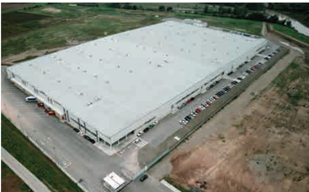
NAVES INDITEX MANRESA (BARCELONA)
