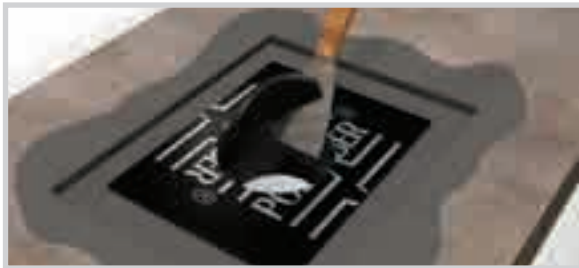
RECORTAR LA PIEZA DE REFUERZO. (Inferior)
