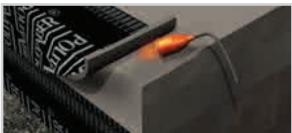
APLICACIÓN DE BANDA DE REFUERZO.
