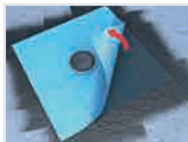
Retirar la cara de plástico siliconado.
