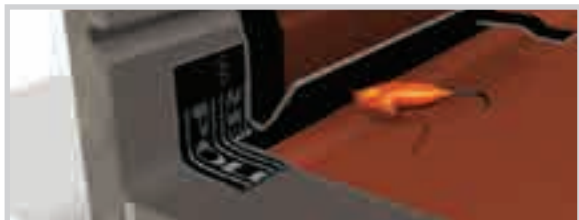
ROZA IMPRIMADA. APLICAR BANDA DE REFUERZO.
