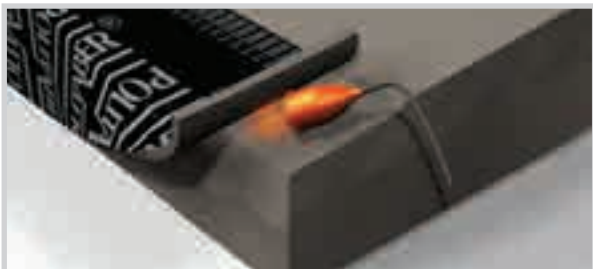
ARRANQUE DE LA IMPERMEABILIZACIÓN.
