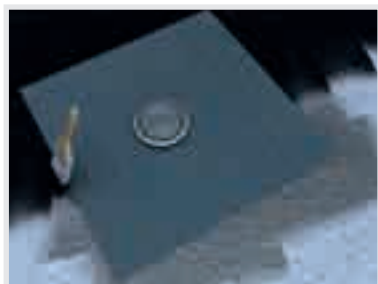
IMPRIMAR zona adyacente al desagüe. (De no haberse imprimado todo inicialmente)
