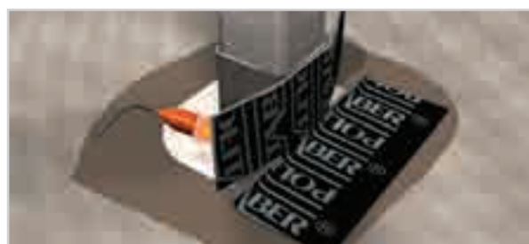
APLICACIÓN DE PIEZA DE REFUERZO INFERIOR.
