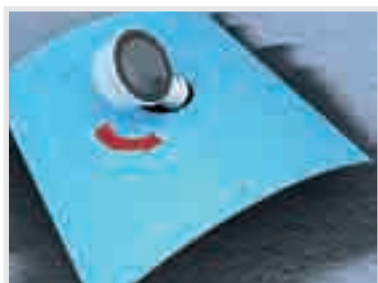
Introducir el desagüe en la pieza de SANIBRIC. Cara siliconada arriba y geotextil abajo.
