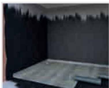
Aplicar SANIBRIC en suelo y paredes. Las láminas remontan en la pared, unos 10 cm.
