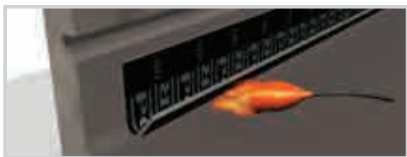
ROZA IMPRIMADA. APLICAR BANDA DE REFUERZO.
