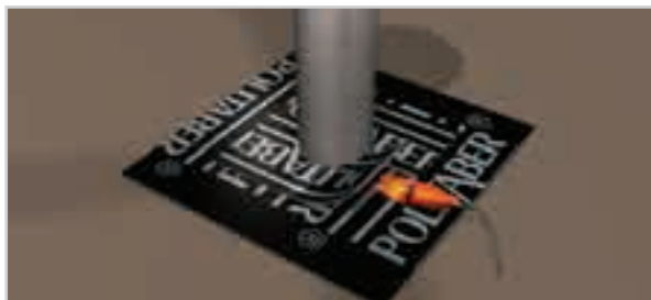
APLICACIÓN DE PIEZA DE REFUERZO INFERIOR.
