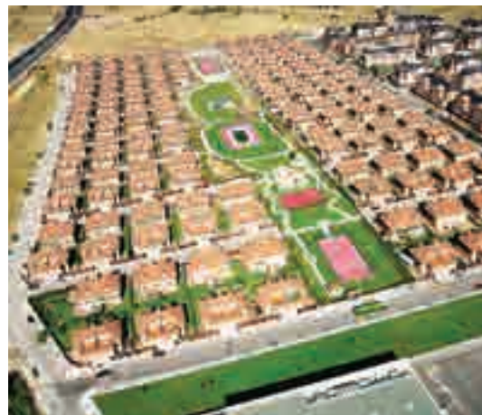
VIVIENDAS BAÑOLAS 1-2-3 LAS ROZAS (MADRID)
