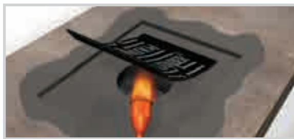
SOLDAR LA PIEZA DE REFUERZO. (Inferior).
