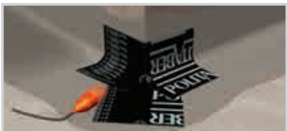
APLICACIÓN DE LA PIEZA DE REFUERZO SUPERIOR. TOTALMENTE ADHERIDA.
