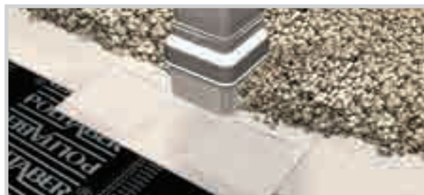
APLICACIÓN DE GEOTEXTIL SEPARADOR Y GRAVA COMO PROTECCIÓN PESADA.
