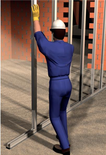
1- Montar la estructura metálica del tabique siguiendo las instrucciones de montaje de los sistemas de placa de yeso laminado. La modulación debe ser de 600 mm entre montantes.
