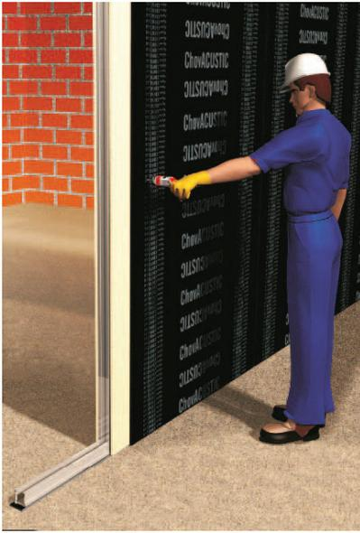
4- Fijar la lámina ViscoLAM® a la placa de yeso laminado utilizando cualquiera de las siguientes formas:
