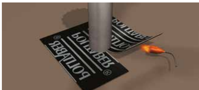
Soporte imprimado. Aplicación de pieza de adherencia
