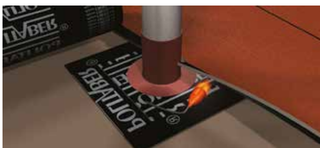
Aplicación de la membrana impermeabilizante
