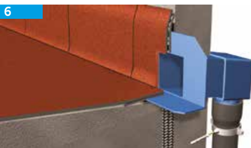
6 Aplicar la pieza de ajuste a la bajante
