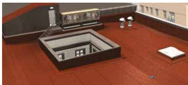
En cubierta adherida, con protección ligera, se hubiera imprimado toda la superficie.
