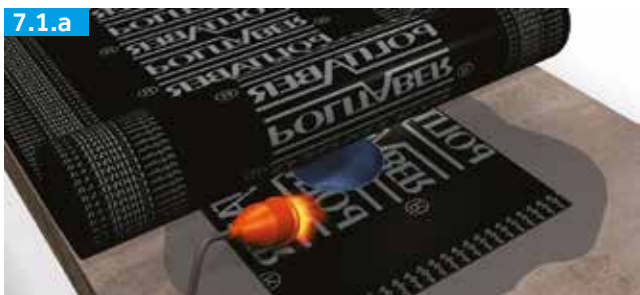
Aplicar la membrana impermeabilizante.
