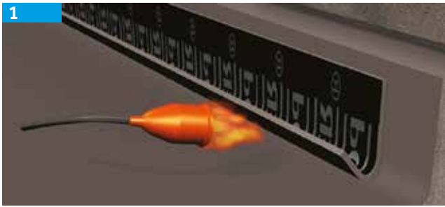
Roza imprimada. Aplicar banda de refuerzo.
