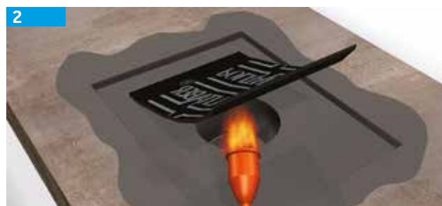
Soldar la pieza de refuerzo inferior.
