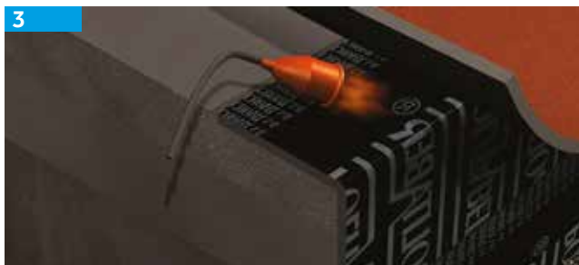
Aplicación de la pieza inicio.
