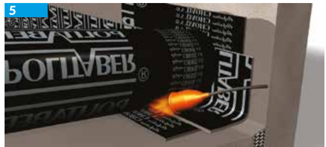
5 Aplicación de la membrana
