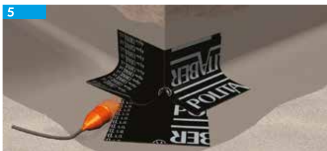
Aplicación de la pieza de refuerzo superior. Totalmente adherida
