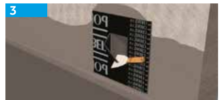
Aplicar banda de refuerzo. Adherente
