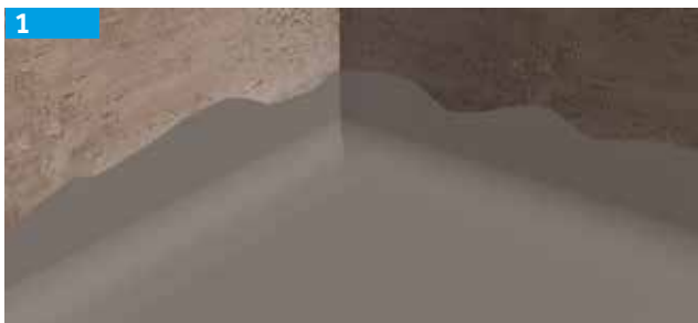
Imprimación. Toda la cubierta
