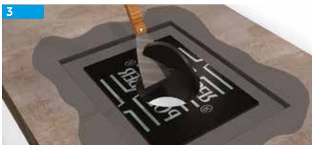
Recortar la pieza de refuerzo inferior.
