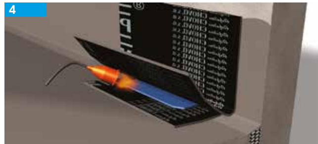
4 Soldar la pieza de refuerzo (superior)
