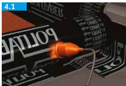
4.1 Aplicación de piezas de acabado: Membrana bicapa
