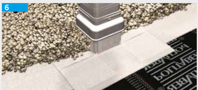
6 Aplicación de un geotextil separador y grava como protección pesada.
