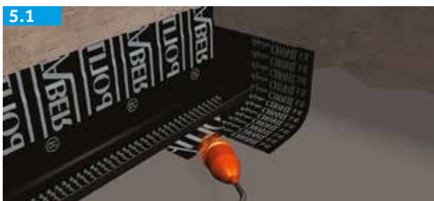
Aplicación de las bandas de refuerzo
