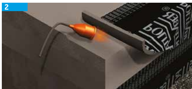
Aplicación de la banda de refuerzo.
