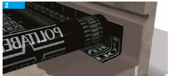
Aplicar banda de refuerzo. Aplicar membrana
