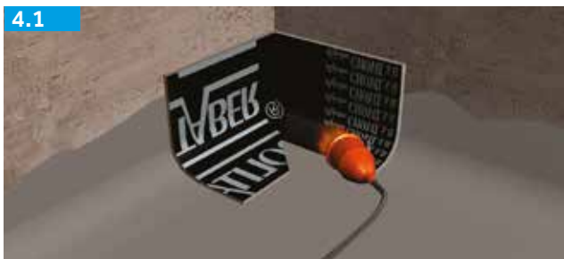
Aplicación de pieza de refuerzo
