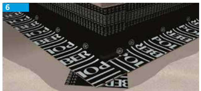
Aplicación de las bandas de refuerzo
